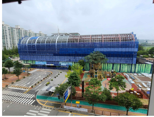
사진2. 사진1. 오산 버드파크 공사현장 2
